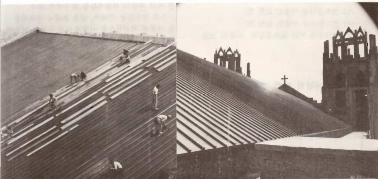
동판 지붕 공사 광경
