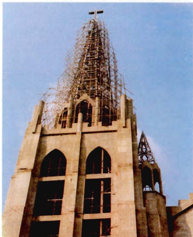
▲ 종탑 외장 동판 공사
