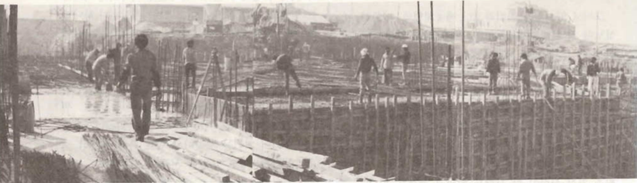
본당과 지하주차장 바닥을 연결하여 콘크리트 작업광경
