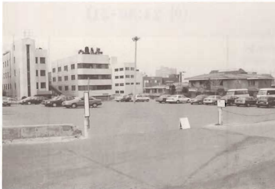
▲ 제2교육관 공사 현장인 뱃바게광장의 전경
