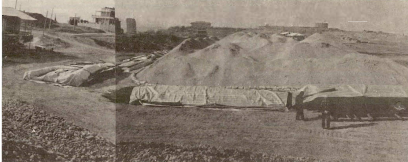
〈강남구 논현동의 새성전 건축 현장. 모래, 자갈, 철근 등의 자재가 속속들어와〉
