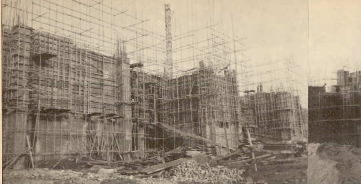
(현재 건축중인 성전 건축 좌편이 본당이고 우편이 교육관인데 교육관 건물은 마지막층인 5층 시공중에 있음)
