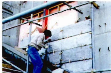
본당 외벽 돌공사
