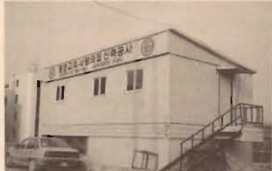
◀공사 현장 사무소
