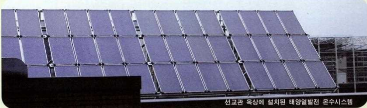
선교관 옥상에 설치된 태양열발전 온수시스템
